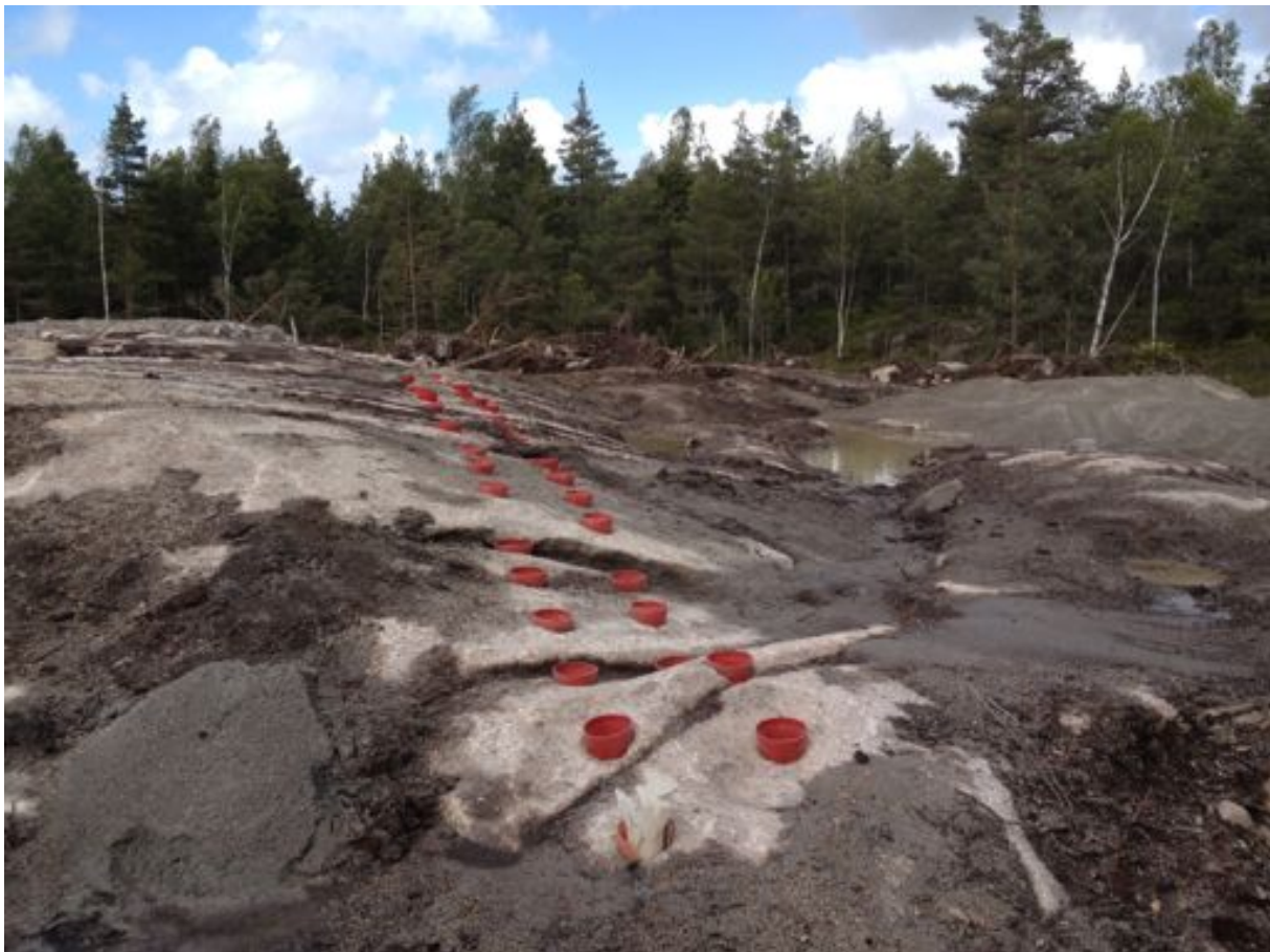
Figur 3.7: Filtret med två rader borrat. På bilden syns också de två mäpositionerna bakom filtret som grå lådor.
