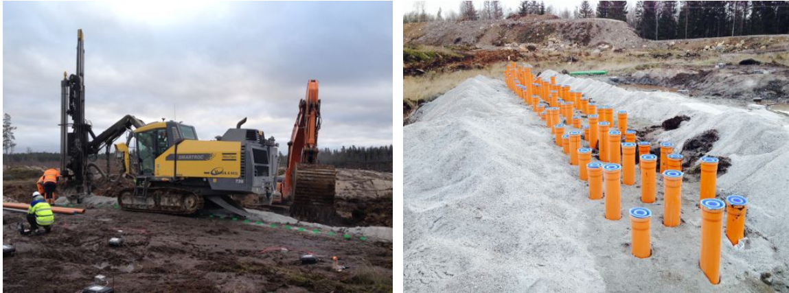
Figur 3.5: Fotografier från konstruktionen av markfiltret. I fotografiet till höger ses det färdiga Steg 2-filtret.
